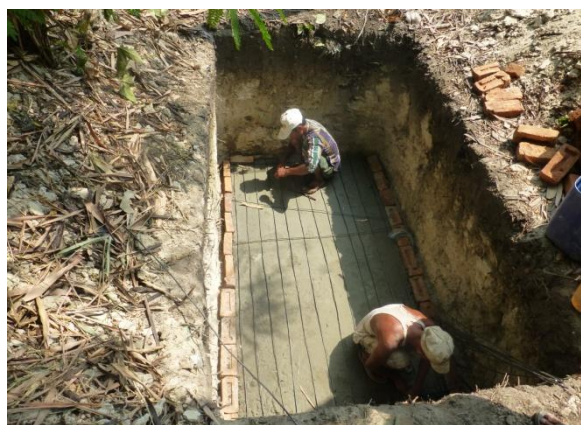
Pouring the septic tank base slab.
